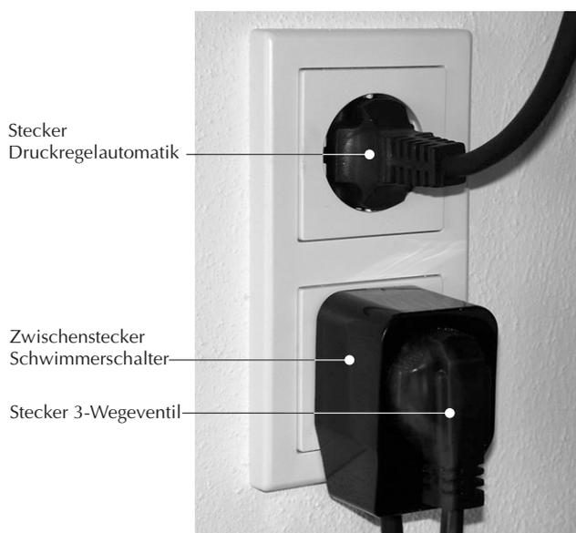
Bild 8 Elektrischer Anschluss der Blue Box 15/4
