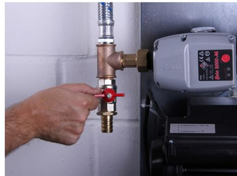
5. Druckabsperrhahn öffnen und Leitung bis zu den Verbrauchern entlüften (z.B. Verbraucher öffnen oder mehrmals betätigen bis Wasser ohne Lufteinperlung konstant fließt)
