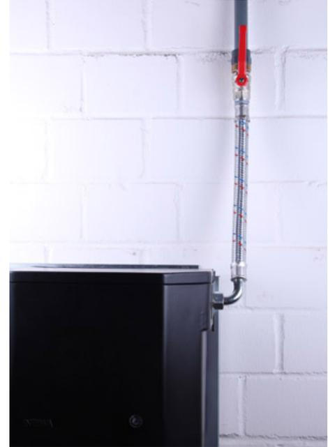
2. Druckabsperrhahn schließen.
