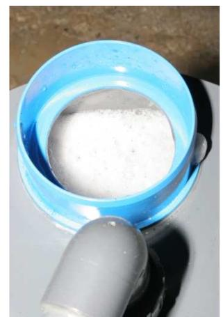
12. Füllen Sie die Filtereinheit C mit Wasser über den Zulauf DN100 bis ca. 5 cm unterhalb des Zulaufs DN100 auf.
