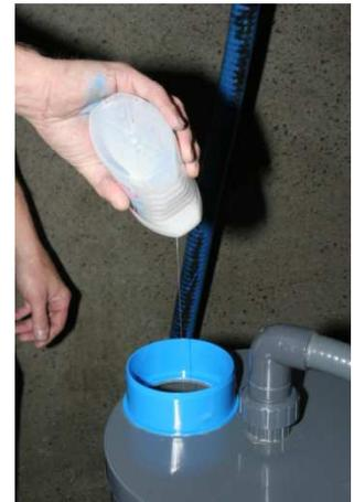
9. Füllen Sie die Filtereinheit C mit ca. 25 l Wasser über den Zulauf DN100. Geben Sie einen Spritzer biologisch abbaubares Geschirrspülmittel in das Wasser. Das Geschirrspülmittel dient zur beschleunigten Wässerung des Filtermaterials und wird später bei der Erstpülung vollständig ausgespült.
